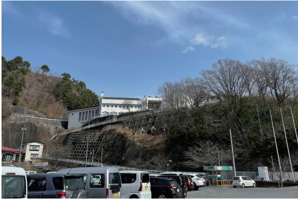
Fig.5 県道 280 号大槌小釜線から見た城山体育館
