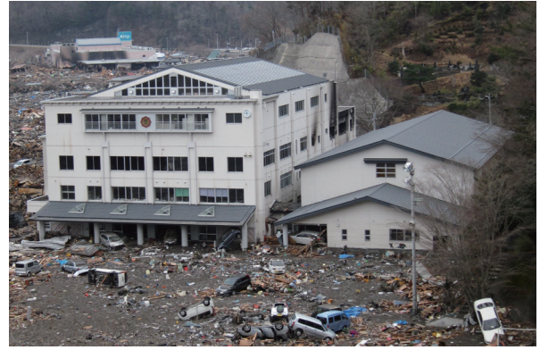
Fig.14 震災当時の大槌小学校（平成 23 年 3 月 18 日）
