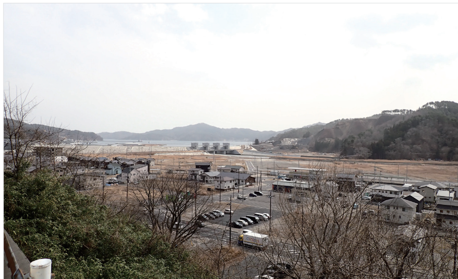
防潮堤と水門に囲まれた市街地（本町方面）、中央が三陸鉄道リアス線大槌駅
